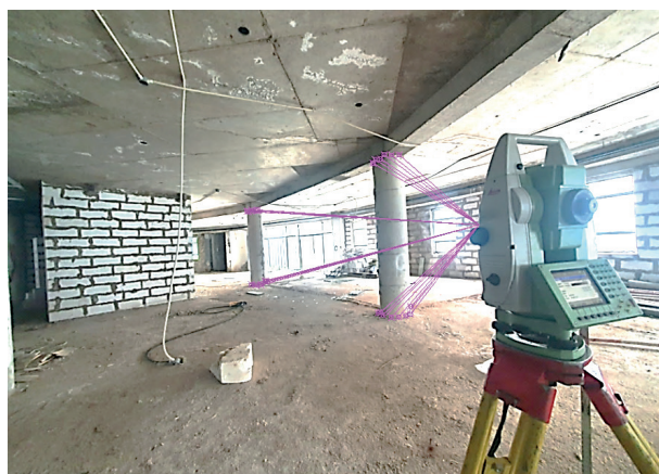
3-сурет – «Leica Geosystems» швейцариялық фирмасының TS1201+ сериялы электронды тахеометр көмегімен ұстындардың геодезиялық бақылауы
