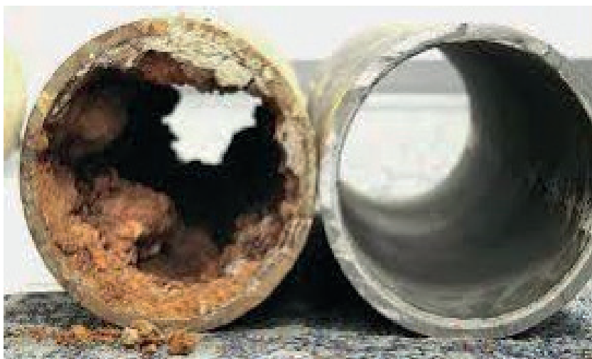
Рисунок 1 - Фрагмент трубопровода с отложениями и без них
