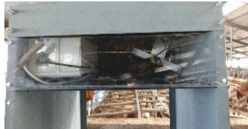
Рисунок 5 – Размещение антенны под определённым углом на специальном кронштейне
